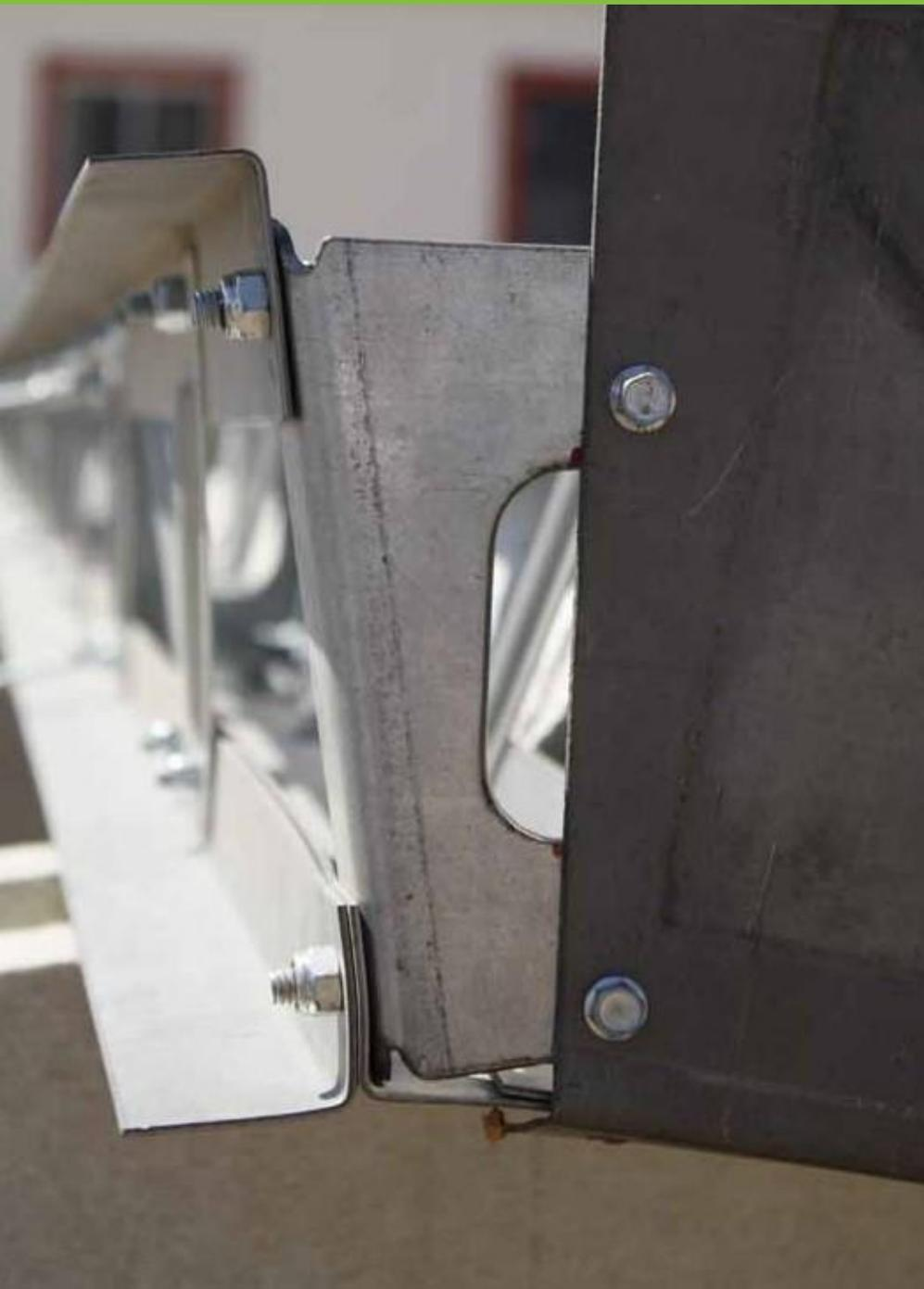
Esta unión se efectúa tras haber colocado en su lugar todos los paneles **neuFöam**, **neuJöist** y sus respectivos separadores. Para esto es necesario unir los dos canales laterales con los **neuJöist** cumbrera. Esto se hace mediante el Bracket (pieza que ya viene ensamblada en la Joist Cumbrera). Para colocar de manera segura los **neuJöist** Laterales, procure seguir los siguientes pasos:
