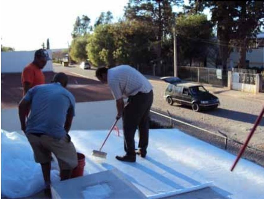
Se debe de aplicar una capa de **neuSéal** SELLADO en toda la superficie a cubrir, y dejar libre de polvo. Una vez sellada la superficie se aplica una capa de **neuSéal** IMPERMEABILIZANTE sin diluir en toda la zona a cubrir.
