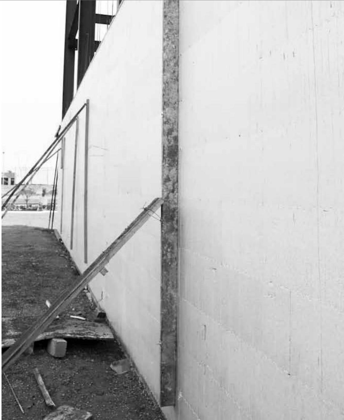
Todos los muros deben de ser apuntalados por ambos lados antes de que se haga el colado, buscando siempre su perfecta vertical. Los puntales no deben de tener más de 2.5m de separación entre ellos. Después del colado, es recomendable volver a revisar los plomos de los muros para asegurar que estén perfectamente derechos.
