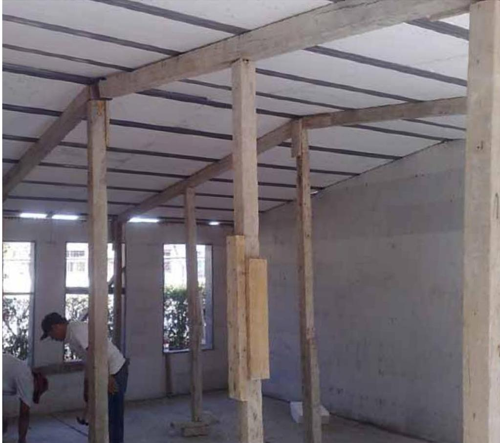
Antes de comenzar a colar es importante reforzar la estructura de la losa de azotea para evitar algún percance o accidente. Por esto se deberán empelar polines armados en forma de “T” con largueros de 4”. Dos por cada agua de la losa. Considerando un claro máximo entre ellos de 2m. Estos deberán de ser colocados de forma perpendicular al sentido de los **neuJöist** y repartidos en espacios iguales en el claro de la obra.
