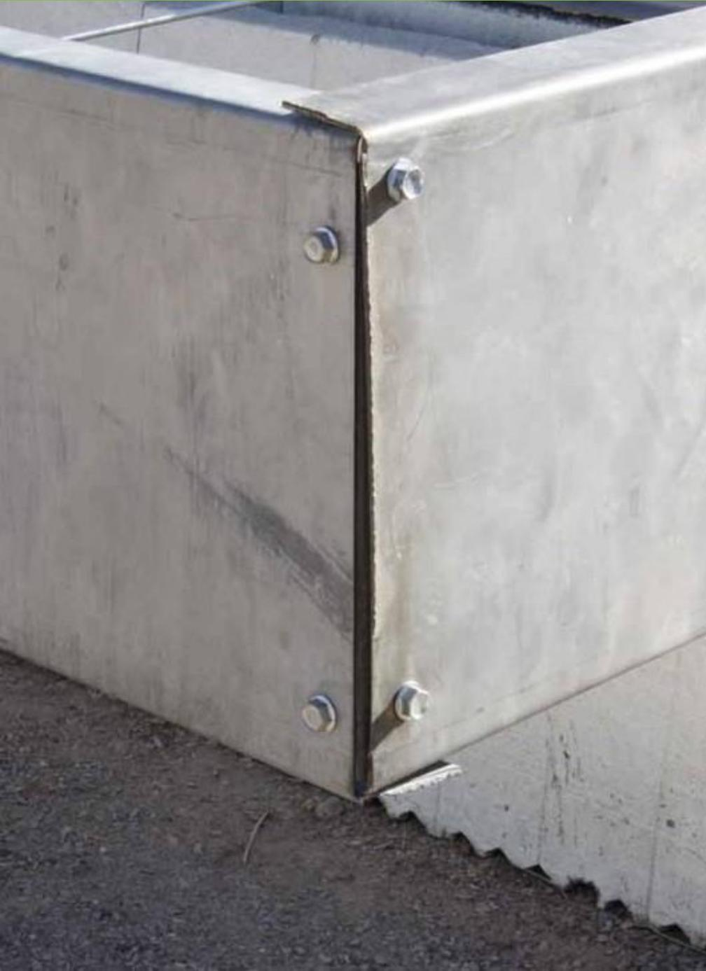
Los canales cabeceros y canales laterales tienen la función de contener el concreto de la losa al momento del colado. Es de vital importancia que estén unidos de forma adecuada mediante el uso del ángulo y pijas de punta de broca.
