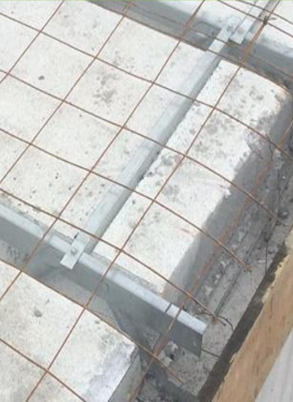
Forma parte imprescindible del sistema, este ayuda a mantener las correctas distancias y alineaciones entre **neuJöist** y a sujetar el **neuFöam** durante el colado.
