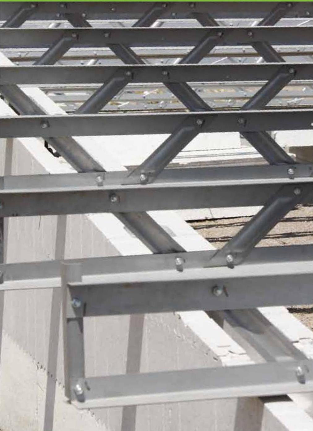
Para hacer de forma correcta el habilitado de la losa se debe de recordar que las **neuJöist** deben ir apoyadas en sus extremos 15 centímetros de los 20 totales de espesor de muro.
